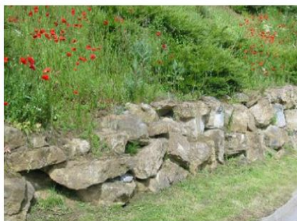
Muret de pierres sèches
