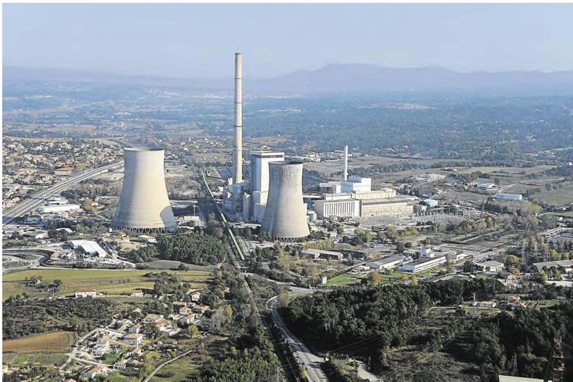
**Pour mémoire, une centrale biomasse produit de l'électricité grâce à la vapeur d'eau dégagée par la combustion de matières végétales, qui met en mouvement une turbine reliée à un alternateur, lequel produit de l'électricité.**
