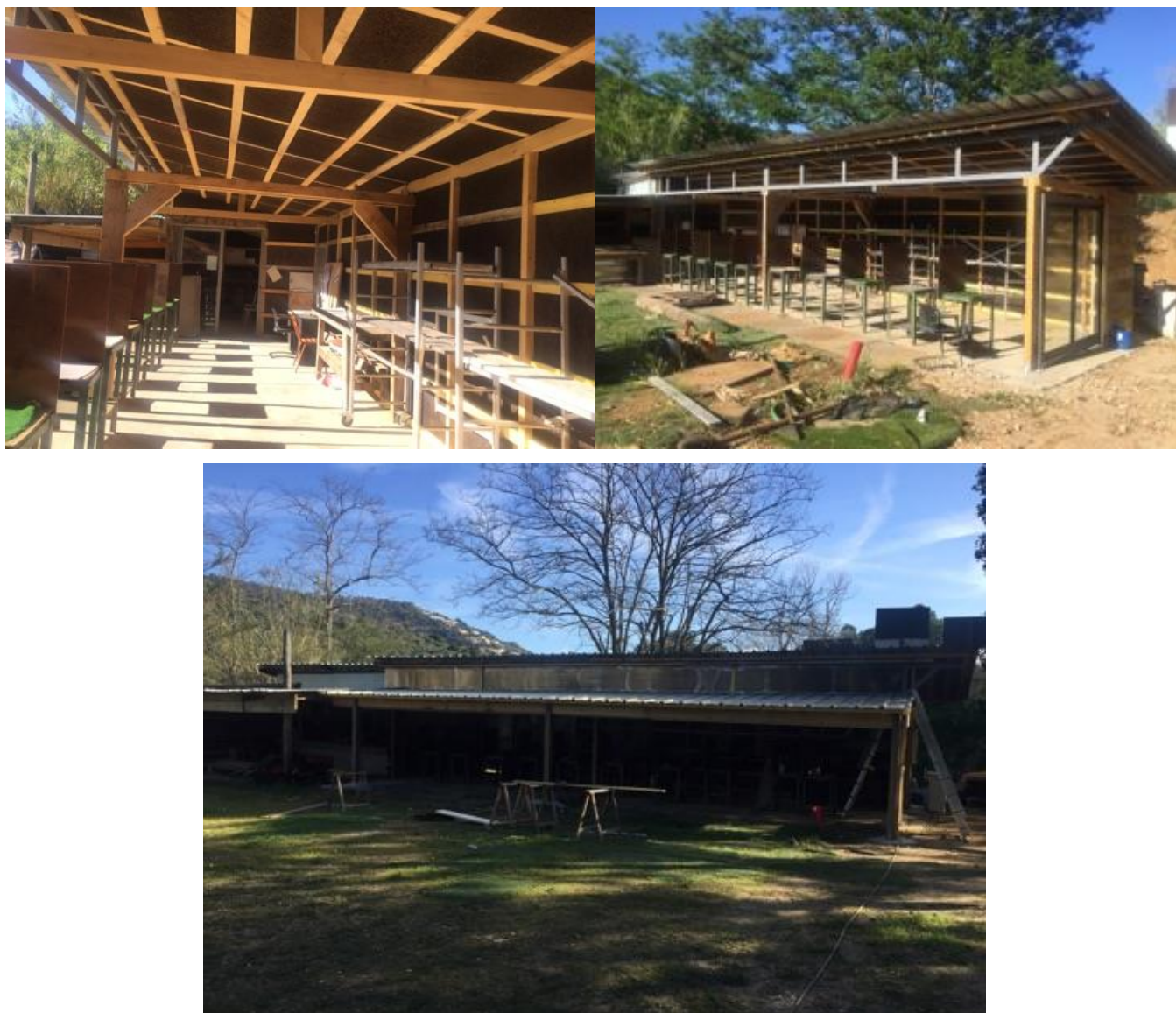
Le pas de tir en chantier
