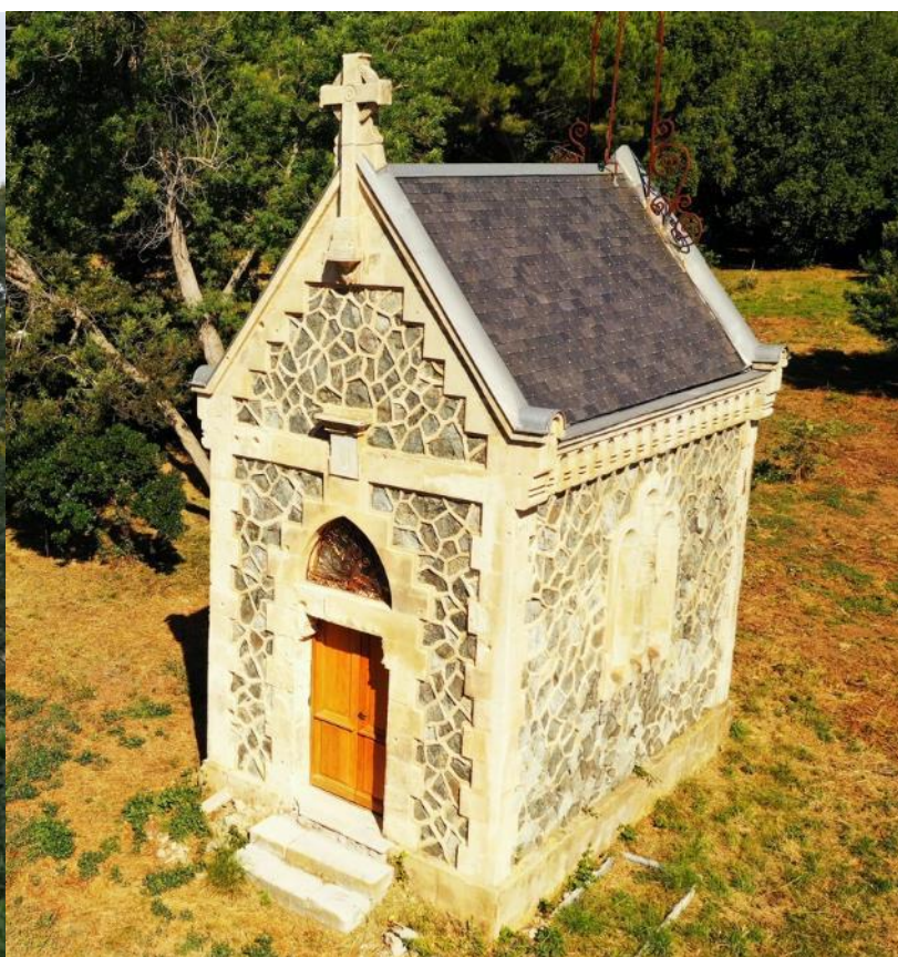
Chapelle après la restauration
