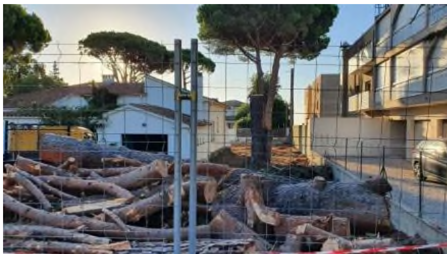
Les arbres abattus afin de permettre la construction
